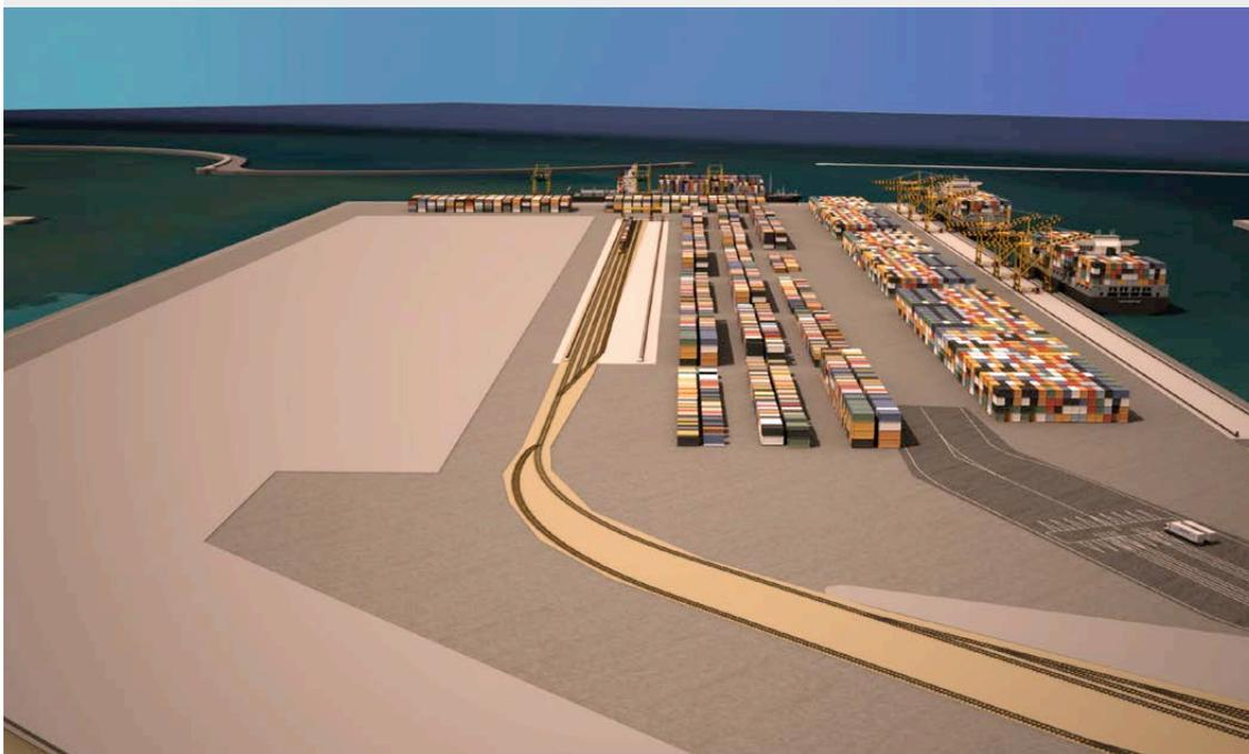
13 - Il terminal contenitori visto da terra nella fase finale: i traffici petroliferi sono stati spostati nella nuova darsena petroli e le banchine del terminal contenitori che vengono utilizzate completamente con due fasci viari e ferroviari.
