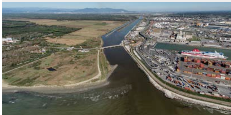
20 - Lo scolmatore d'Arno alla foce
