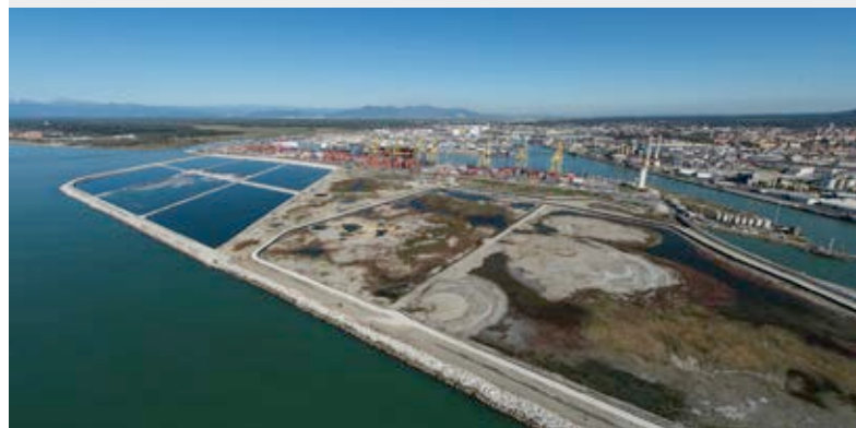
23 - Le vasche di colmata esistenti
